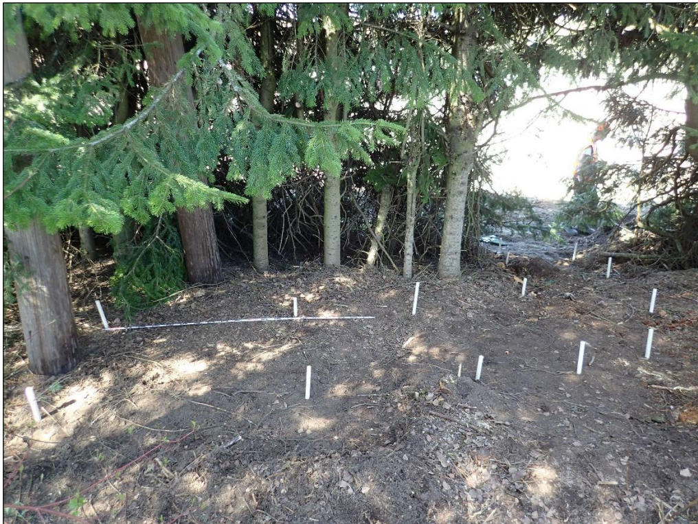
Kaivausalue raivaukseen ja kaivalueen paalutuksen jälkeen. Luoteeseen.
