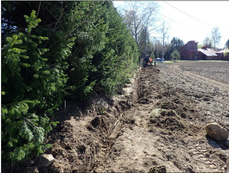
Valvotun kaapeliojan eteläistä keskiosaa. Kuusiaidan alaosassa pilkottaa vaalea puupaalu, joka on kaivausalueen länsireunan kulmapaalu. Lounaaseen.
