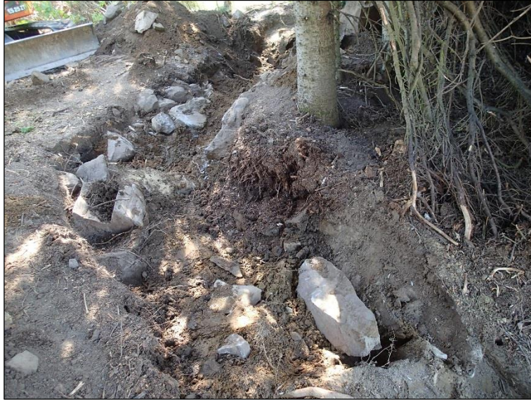
Kaivausalueen länsilaidan pohjamaahan on kaivettu lapiolla maakaapelin mentävä oja. Etelään.
